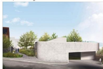
Zufahrt zum Parkhaus von der Holzapfelstraße
