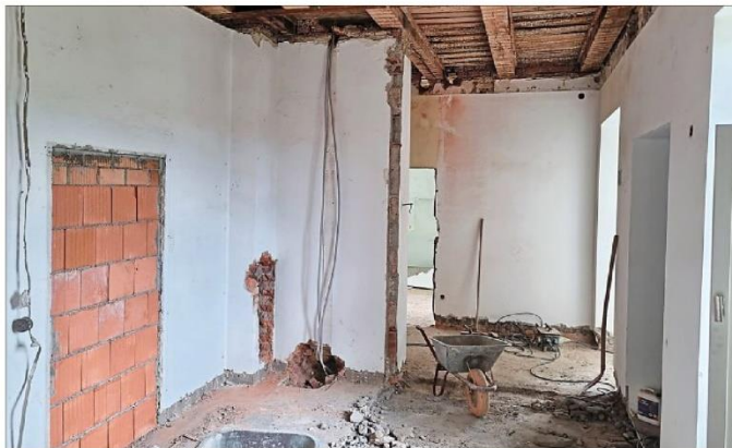
Im Erdgeschoss des Rathauses hat die Sanierung begonnen. Vor allem der Eingangsbereich soll modern und großzügiger gestaltet werden. Foto: Jürgen Hirtreiter
