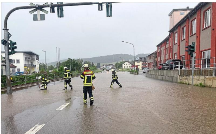
Kein ungewöhnlicher Anblick: Bei starkem Regen steht die Schullerer-Kreuzung unter Wasser.
