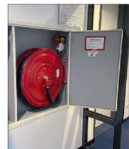
Die Wandhydranten werden gegen Feuerlöscher ausgetauscht.
