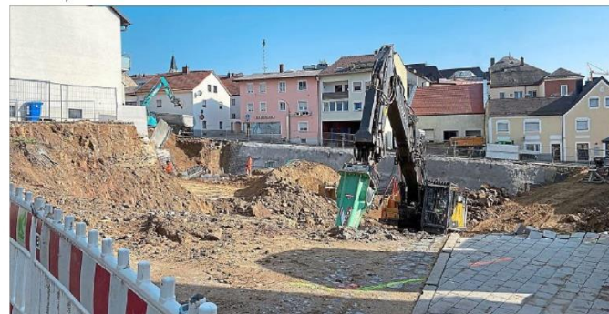
Baustelle Parkhaus: Den Auftrag für die Baumeisterarbeiten vergab der Stadtrat in seiner nichtöffentlichen Sitzung an die Fa. Josef Rädlinger Bau GmbH.
