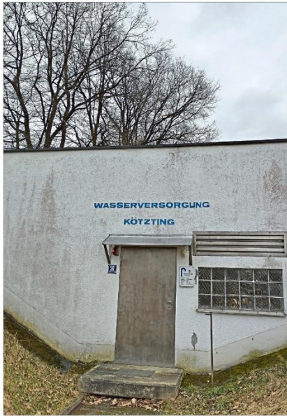
Besonders wichtig sieht er nicht aus, die Wasser-Hochbehälter im Ortsteil Arndorf – in der Planung der Versorgung der knapp 7.500 Einwohner nimmt er aber eine zentrale Rolle ein und soll nun noch weiter ausgebaut werden, da er nach der Erschließung neuer Quellen die Stadt noch unabhängiger vom Fernwasser machen soll. Foto: S. Weber
