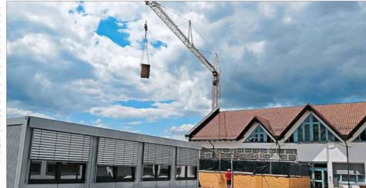
Der Kran über dem Sonderpädagogischen Förderzentrum dreht sich auch in den Sommerferien weiter.
