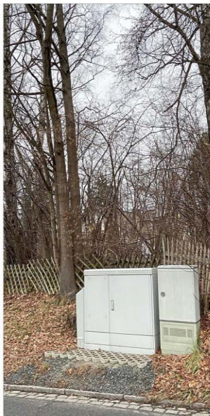
Bisher hieß die Devise FTTC: Glasfaser wird bis zum Verteilerkasten verlegt. Künftig soll das Glasfaserkabel direkt bis zum Haus angeschlossen werden (FTTH). Diese Dienstleistung wollen in Bad Kötzing nun Telekom und Leonet anbieten. Foto: Doris Zitzelsberger
