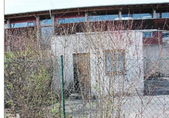
Auch das Bürogebäude wird erneuert.
