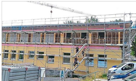
Innerhalb nur weniger Wochen wurde auf dem bestehenden Gebäude aufgestockt.
