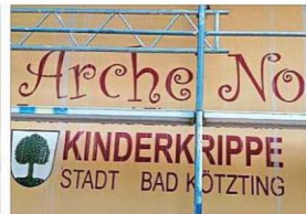
Noch im August wird an der Arche gebaut.
