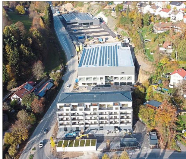
Blick aus der Luft auf die Baustelle an der Westumgehung. Gut zu erkennen sind die Solarmodule auf den Dächern von Edeka und Aldi (im Hintergrund). Foto: Jürgen Hirtreier
