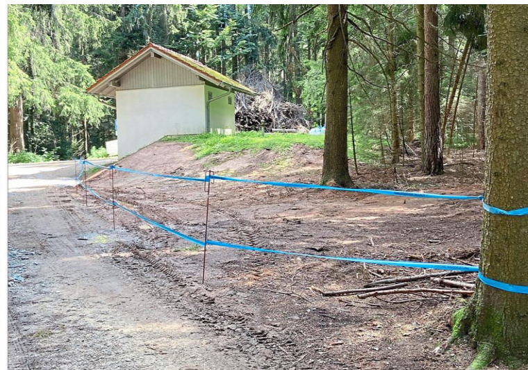
Der Hochbehälter Waid wird an das Fernwassernetz angeschlossen, die Leitungen wurden bereits verlegt.
