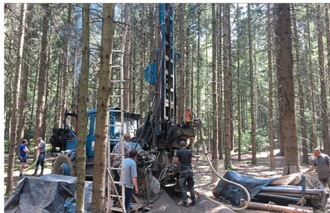
Um neue Quellen zu finden, wurden drei Probebohrungen unternommen, zwei davon verliefen erfolgreich.
